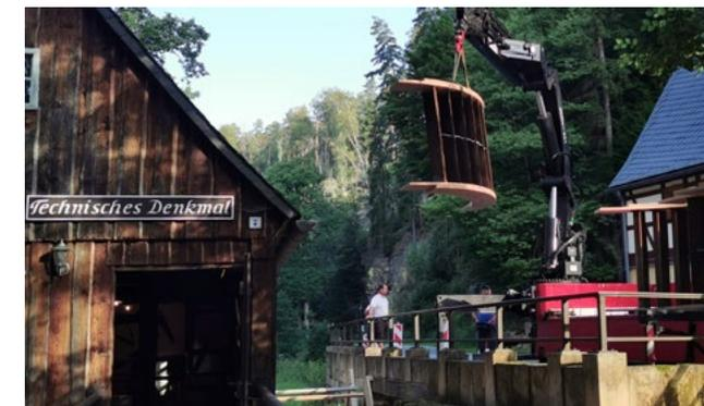
Das neue Mühlrad wurde in mehreren Teilen vor Ort im Kirnitzschtal aufwendig montiert.
