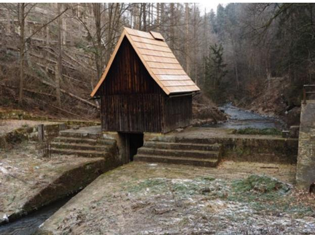
Das unscheinbare kleine Haus ist der Wetterschutz für die Stauvorrichtung der Niederen Schleuse.
